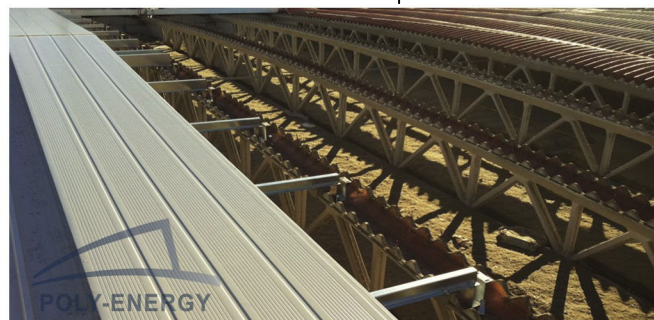
4. Nuova copertura in pannello sandwich ad alto rendimento..
