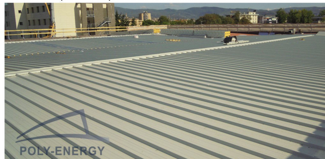
4. Nuova copertura in pannello sandwich ad alto rendimento..
